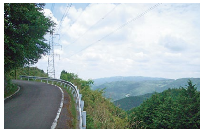
▲ 鉄塔付近から茨木方面を望む
